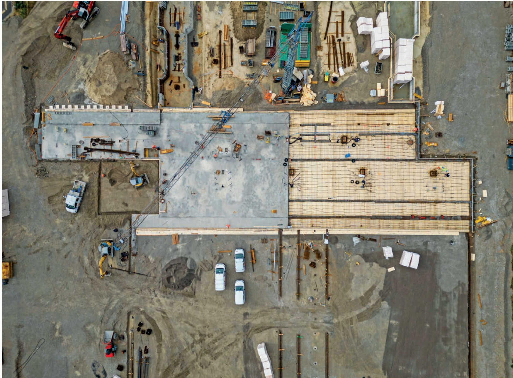
Eine Fläche von acht Turnhallen wird verbaut – schon bald wächst die Holzkonstruktion in die Höhe.
