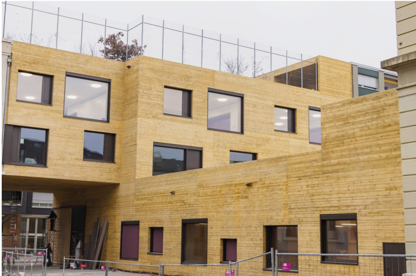
Des écoles biennoises doivent être assainies rapidement. L'an dernier, celle de la Plänke, en centre-ville, a connu d'importants travaux. ARCHIVES
